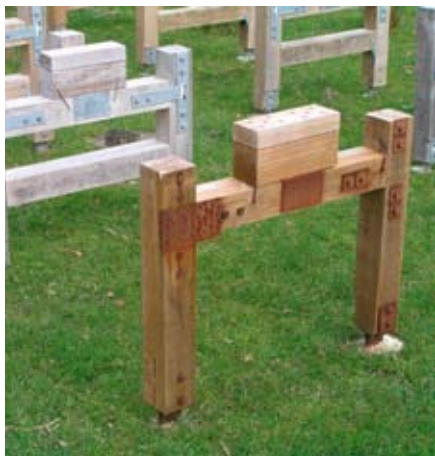
Exposition des éléments de fixation à la corrosion.
