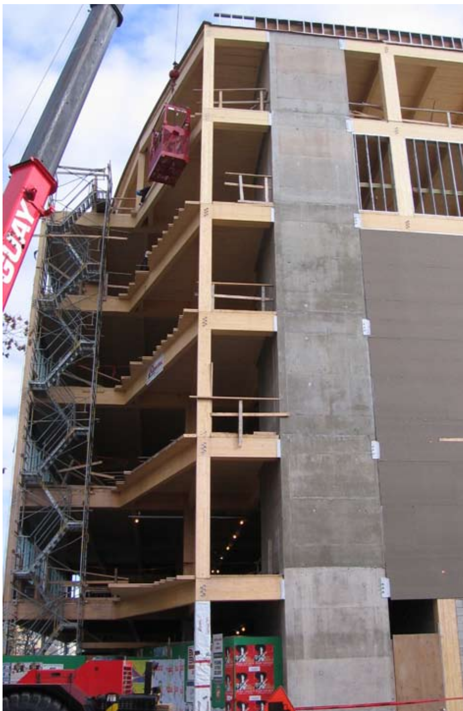
Une structure à six étages à poteaux et poutres en bois lamellé-collé avec noyau en béton armé (immeuble CSN FondAction) à Québec, Canada, montre comment les produits en bois peuvent être utilisés avec d'autres matériaux.
